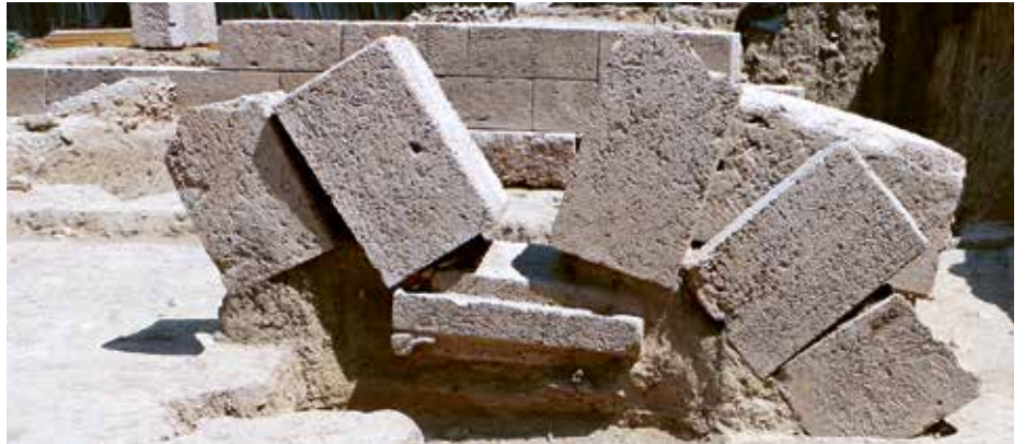
Πεσμένη αντηρίδα του τοίχου αντιστήριξης. Collapsed pillar of the retaining wall against the hillside.
