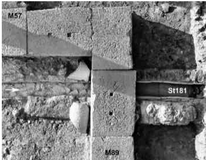
Fig. 6 Conduit d'évacuation des eaux St181 à travers l' atrium (état romain)
